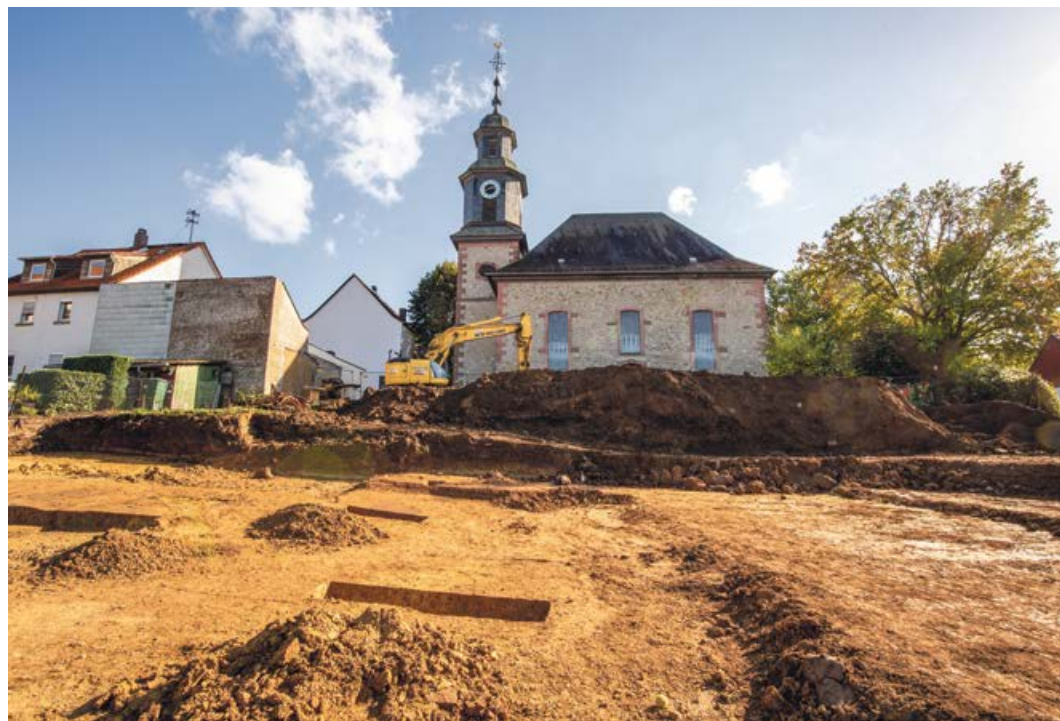
Das Pfarr- und Gemeindehaus der Michaeliskirche wurde abgerissen, hier entsteht ein Neubau.
